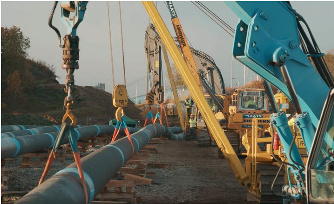
Joonis 4.14 Meretoru paigaldamine Paldiski FSRU ühendamiseks
